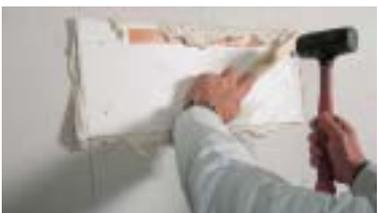
A l'aide d'une cale de protection, enfoncer fermement le caisson au marteau. Les angles crénelés s'incrusteront dans le plâtre.
