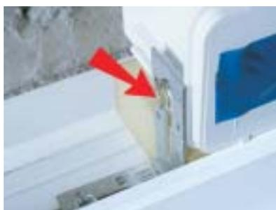
Elle se fait par les extrémités de l'entrée d'air à l'aide d'équerres et de visseries du commerce sur la queue d'aronde du dormant. L'ensemble est ainsi réglable dans les trois dimensions.
