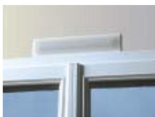
Clipser la grille intérieure de façon à masquer le passage d'air.
