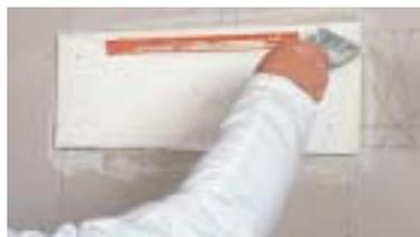
Arrivé en butée, il ne reste plus qu'à nettoyer le surplus de mortier et la façade.
