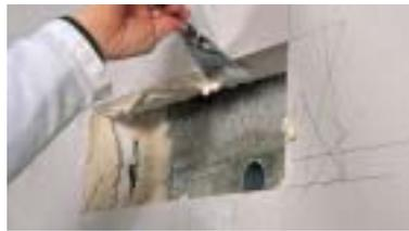
Enduire largement les parois internes du doublage de mortier adhésif sauf au passage de l'emboîture. Même chose pour le caisson, seuls les angles crénelés ressortent des faces.
