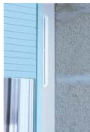
Dans ce cas de figure, prendre la précaution de placer le rail de volet de façon à **ne pas obstruer la prise d'air extérieure**.
